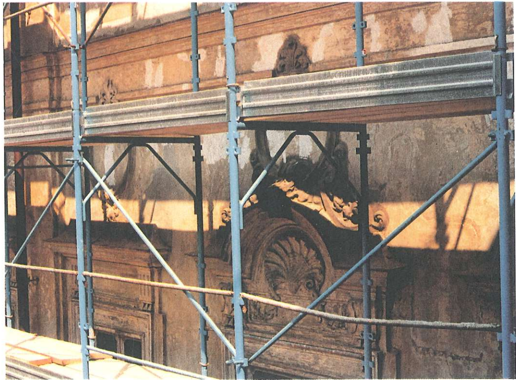
Particolare delle facciate del cortile d'onore durante i lavori di pulitura e di ripristino.
