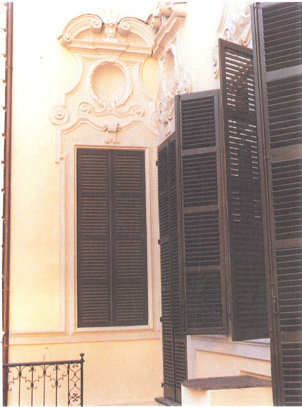
Apertura cieca dopo il restauro e l'esecuzione del trompe l'œil.
